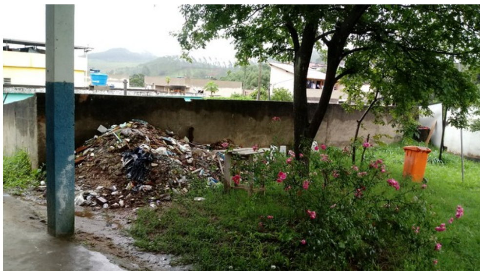
Entulho amontado na frente da unidade.
