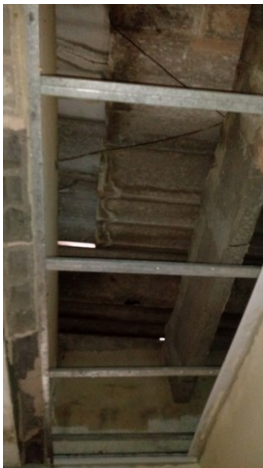
Teto do corredor de acesso à nova ala.
