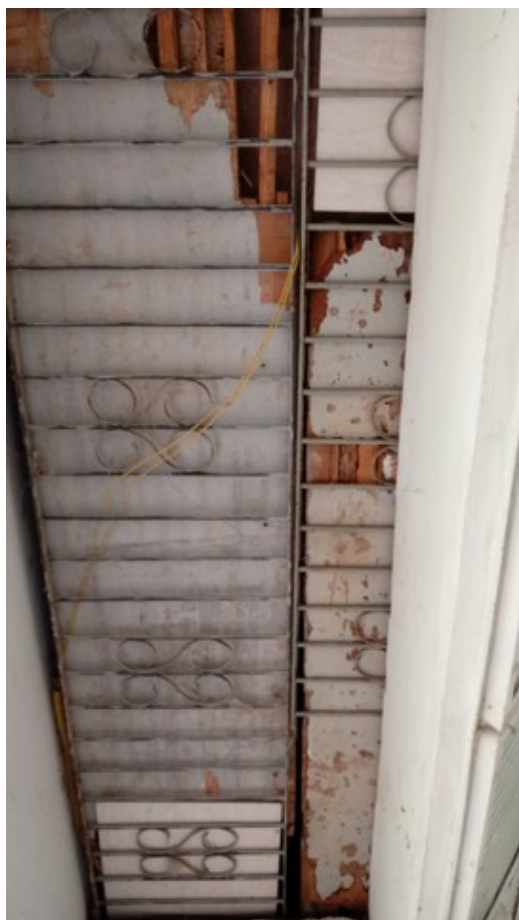
Forração do teto da entrada da Unidade
