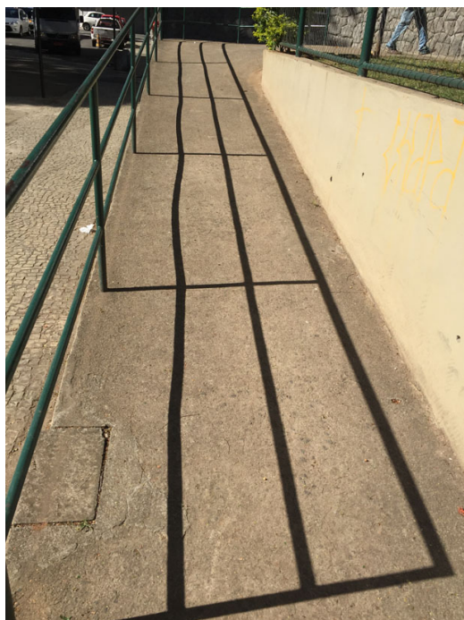
Rampa e corrimão para acesso à quadra
