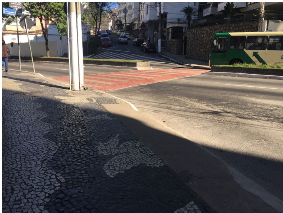
Rampas de acesso na calçada para portadores de necessidades especiais
