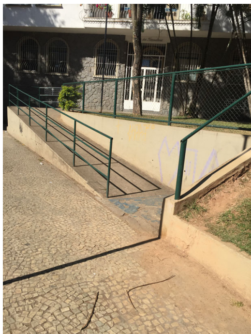
Rampa e corrimão para acesso à quadra
