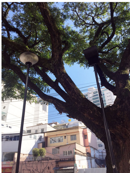
Iluminação da praça em bom estado de conservação
