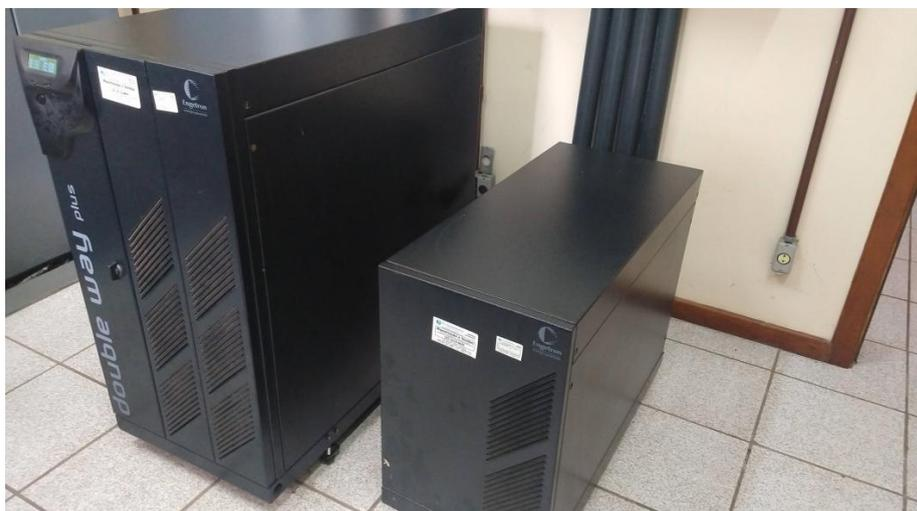
Figura 02 - Nobreak e transformador de isolação
