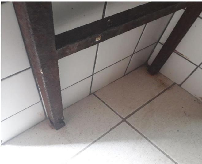
Substituir a escada marinheiro e recompor o forro de gesso, fazendo novo alçapão com requadro de alumínio para acesso ao forro, dentro do banheiro masculino do 3º andar
